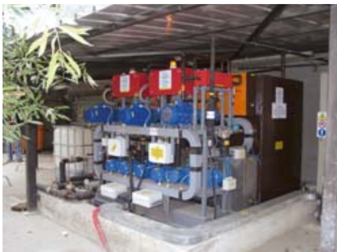
Système de production à micro-émulsion pour brûleurs au mazout équipés de pompes KRAL
