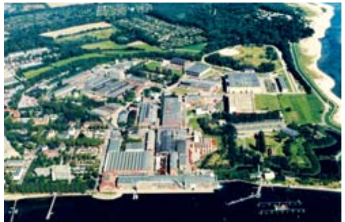
Photographie aérienne de la société Caterpillar Motoren GmbH & Co. KG, à Kiel
