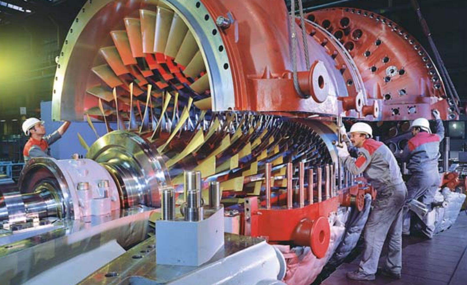
La turbine GT13E2, d'une puissance de 165,1 MW en phase d'installation
