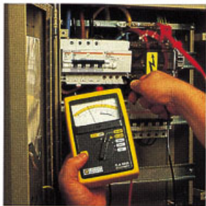
Vérification de la continuité des connexions de terre.
