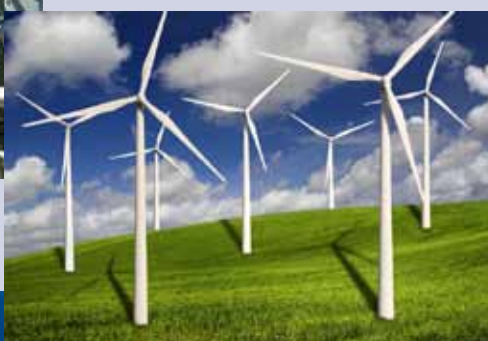
Windkraftanlagen Wind turbine generator
