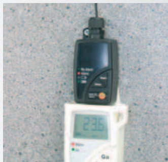
Recopie du signal d'alarme
