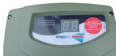
Coffret de commande prêt à raccorder. Affichage digital des défauts (fusibles, rotation, alimentation).
