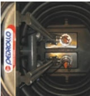
Etanchéité fond de cuve parfaite, montage des pieds d'assise sur platine PVC rapportée (pas de perçages en fond de cuve)
