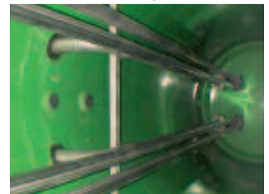
Tuyauterie inox sur demande
