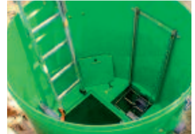
Plancher technique avec panier dégrillage
