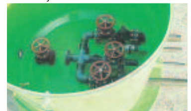
Chambre à Vannes
