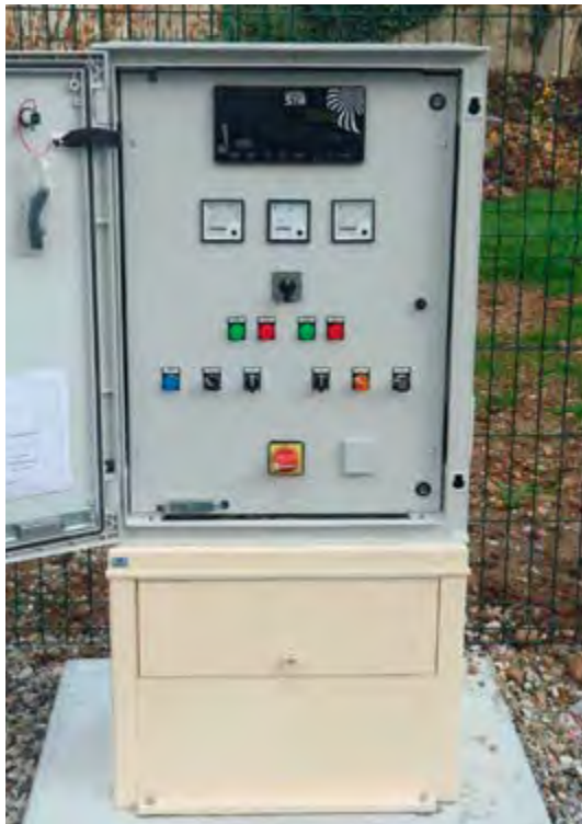
Armoire CPR pour poste de relevage
