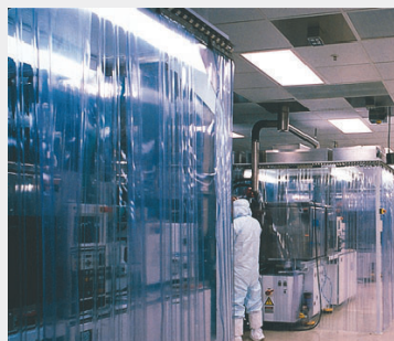
Installation de deux Modulac avec luminaire goutte d'eau et rideaux lamellés translucides
