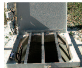
Tampon polyester sur coffrage perdu
