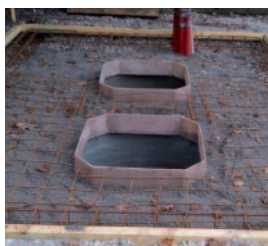
Pré moules de dalle de propreté
