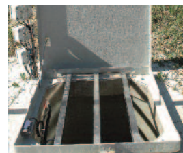
Tampon polyester sur coffrage perdu
