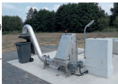
dégrilleur automatique
