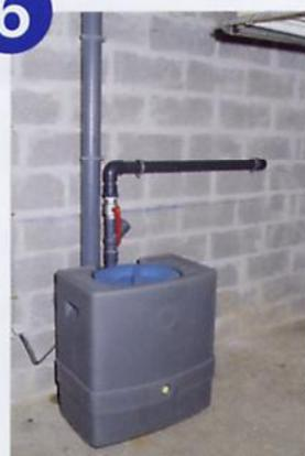
Raccordez la station sur une prise protégée, ouvrez la vanne, faites un essai en faisant couler de l'eau.
