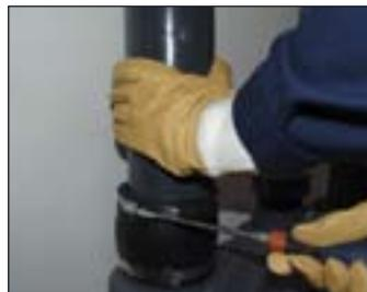
2. Découpez les orifices disponibles en fonction des canalisations existantes. Positionnez la conduite dans le raccord DC 115 et serrez avec un tournevis. C'est prêt !
