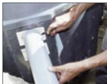
3. La canalisation de refoulement se raccorde soit par collage dans les opercules soit par vissage sur le raccord fourni.
