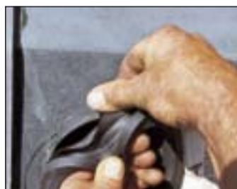
2. La canalisation d'arrivée est raccordée rapidement grâce à la face plane et au joint fourni.
