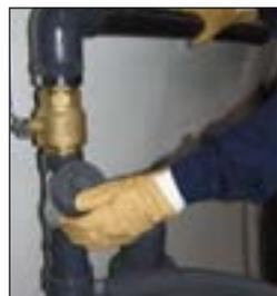
3. Raccordez la conduite de refoulement sur le bloc clapet-vanne. N'oubliez pas l'évent à l'arrivée.
