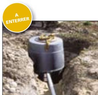
1. Selon la notice de pose simple et détaillée, la station est posée sur un lit de sable et lestée selon la nature du terrain.
