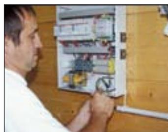
5. Pour vous éviter tout souci un technicien spécialisé effectuera les branchements électriques au coffret de commande ainsi que les tests de fonctionnement. La station est opérationnelle.
