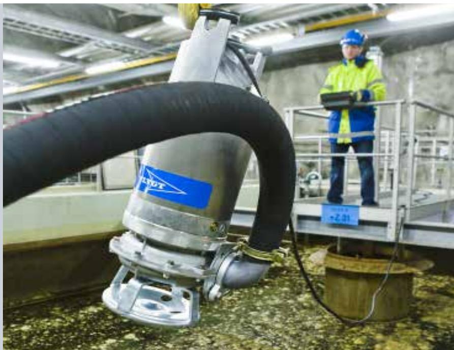
**La série Flygt D 2600 est spécialement conçue pour le pompage de boues et de liquides chargés, sans colmatage de la partie hydraulique.**
