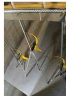
Le système à barre de guidage permet d'accéder facilement aux agitateurs.
