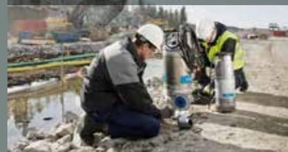
Le choix idéal pour toutes les tâches d'assèchement sur chantier, qu'il s'agisse de drainage actif ou passif de l'eau souterraine. Grâce à leur construction compacte, ces pompes portables peuvent être déplacées librement sur le site une fois leur tâche accomplie.
