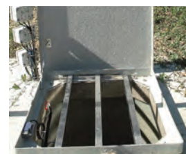
Tampon polyester sur coffrage perdu
