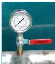
Manomètre à bain d'huile au refoulement pour mesure de pression.
