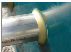
Une traversée de paroi entre la cuve et le refoulement parfaitement étanche .
