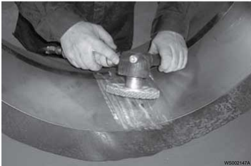
Рис. 49: Полировка сварного шва
