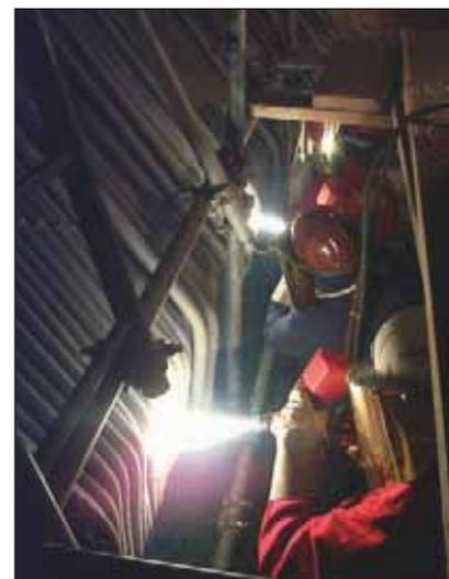
*Revêtement de tubes de chaudière d'incinération réalisé sur site*
