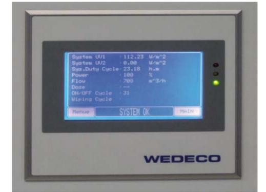
Les composants électroniques sont alors installés dans une armoire séparée qui fournit une grande sécurité électrique et facilite la maintenance. L'armoire de commande comprend les ballasts ECORAY et un dispositif sophistiqué de surveillance de la commande et du système. Des armoires de type 4X/IP66 sont disponibles pour les installations à l'extérieur, rendant ainsi inutile la construction d'un local.
