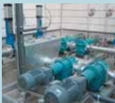
**Dans un abattoir**, il faut broyer en morceaux les différents abats de l'animal tel que le foie, l'estomac, la graisse, les flottations et autres. Ceux-ci sont ensuite transportés dans des containers vers d'autres traitements. Solution technique par Börger : Un Unihacker, équipé d'une ouverture agrandie et d'une trémie verticale
