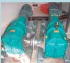
**Dans les stations d'épuration** se forme des filasses concentrées sous l'apparence de tresses. Celles-ci sont à l'origine de nombreuses pannes car ces tresses s'enroulent dans le corps des pompes, ou dans les pales des agitateurs et provoquent des dysfonctionnements dans les centrifugeuses et les réservoirs. Le Unihacker rend ces filasses inoffensives en les broyant en de petits tronçons sans danger pour les autres équipements.
