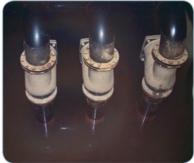
Les vannes à guillotine, avec commande par volant, sont en mesure d'exécuter plusieurs fonctions et sont utilisées comme des organes de retenue pour régler le débit d'un tuyau ou isoler temporairement un secteur de l'installation.
