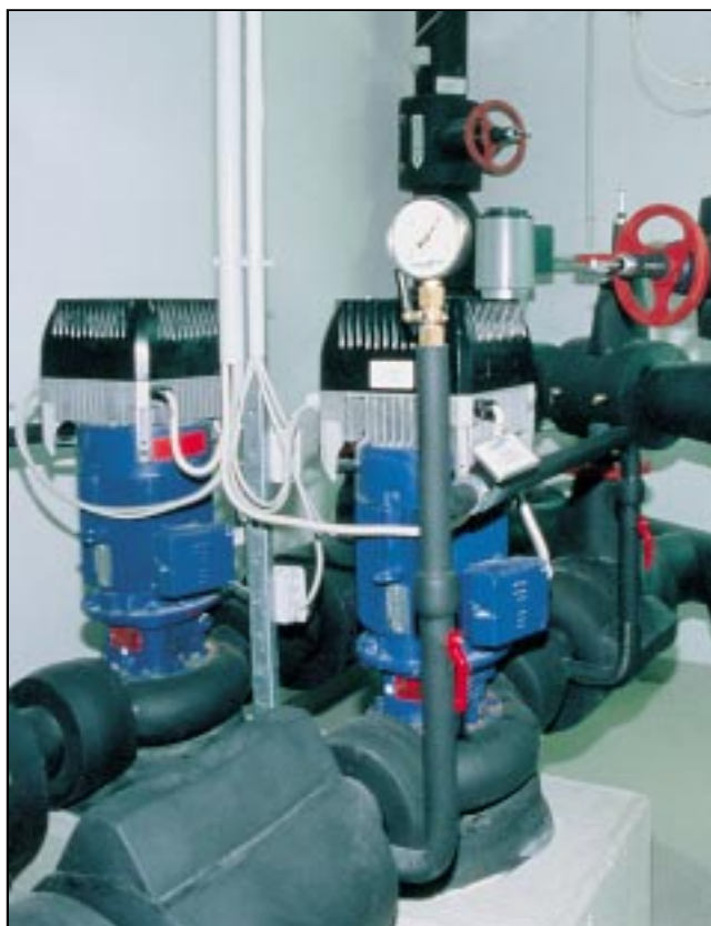
Pompes de circulation d'eau de refroidissement
