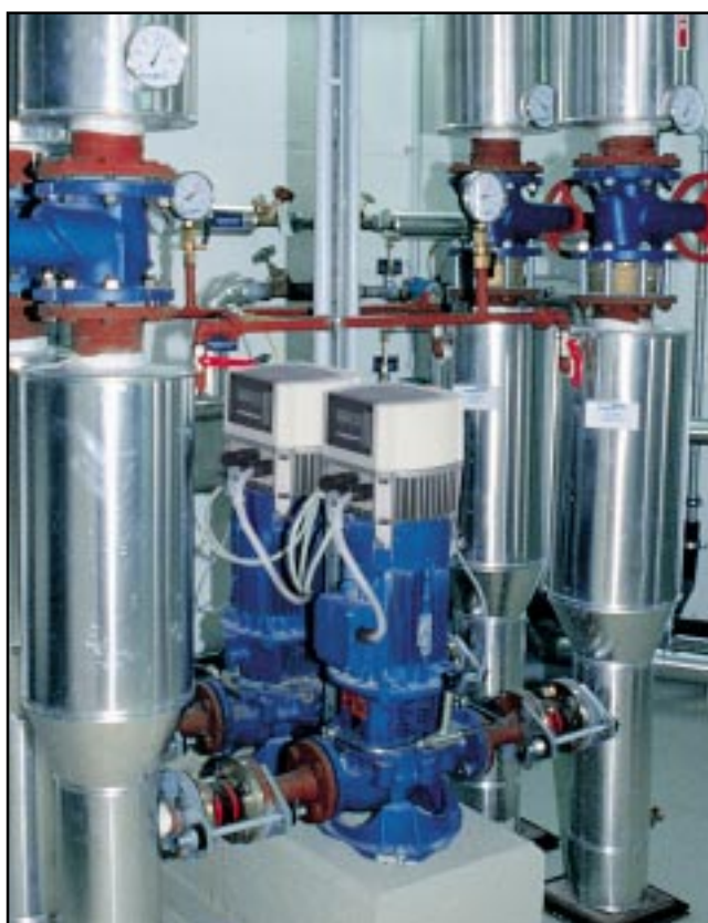
Pompes de circulation pour échangeur thermique
