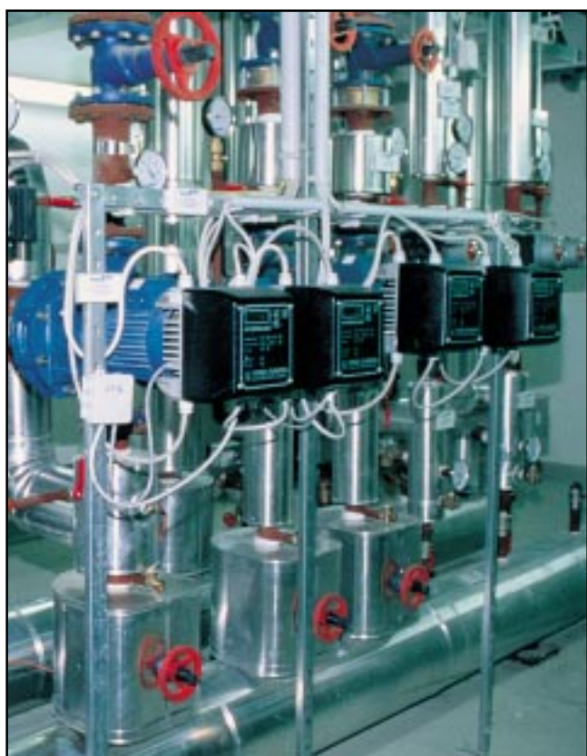
Pompes de circulation de chauffage
