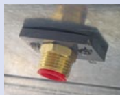
Bouchon purge fileté sur caisson
