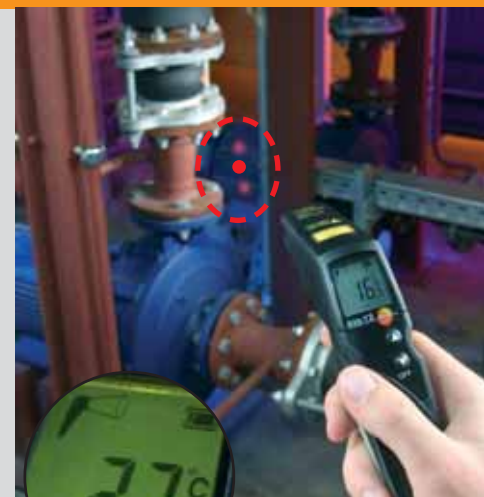
Contrôle départ/retour Lecture aisée des données grâce à l'écran rétro-éclairé
