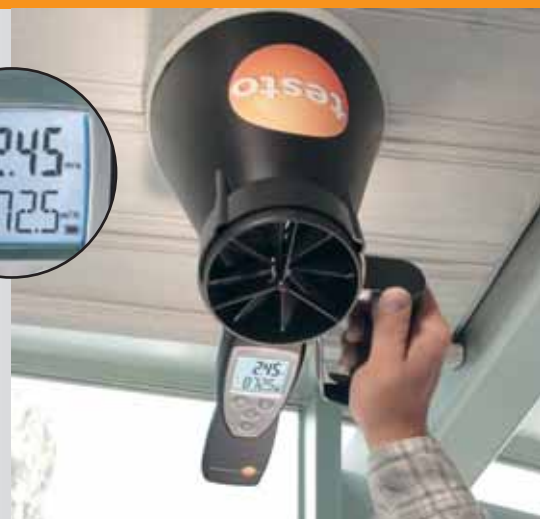
Contrôle du débit d'une V.M.C.
