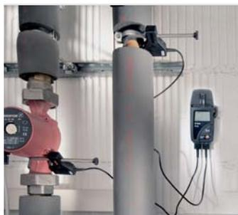
Mesure des températures départ/retour du chauffage des locaux et de la préparation eau chaude sanitaire
