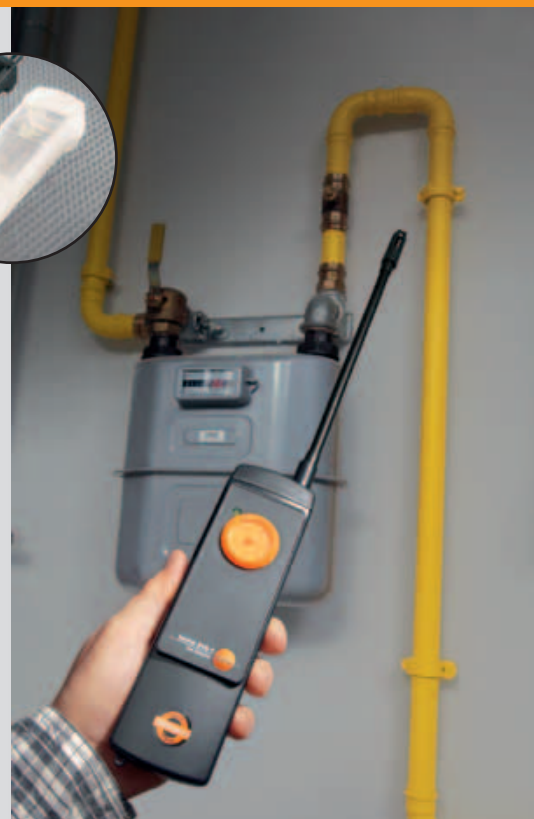
Contrôle d'étanchéité sur des conduites de gaz d'installations domestiques
