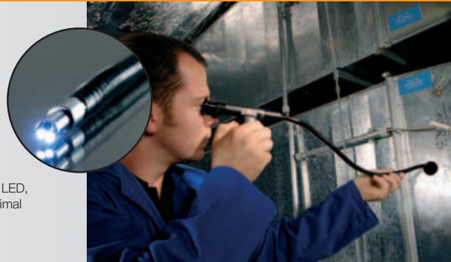
Contrôle en gaine de climatisation, avec une gaine de flexibilité moyenne
