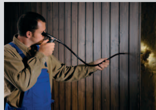
Contrôle d'isolation par l'utilisation d'une gaine rigide decabon
