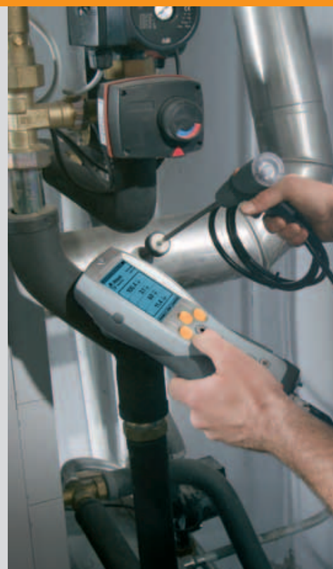
Analyse de combustion sur un brûleur
