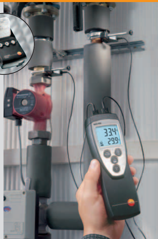
Mesure de la température différentielle (entrée/sortie)
