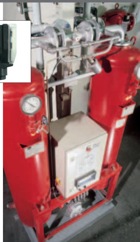
Avec les déshydrateurs, le testo 6740 surveille non seulement l'humidité résiduelle de manière très fiable, mais il sert également de manière optimale pour de faibles frais d'exploitation.
