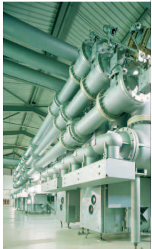
Dans les hautes et moyennes tensions, SF<sub>6</sub> sert à la prévention des étincelles. Le testo 6740 surveille l'humidité continuellement - ainsi les cycles d'échange des gaz coûteux peuvent être maximisés, et les dommages évités.
