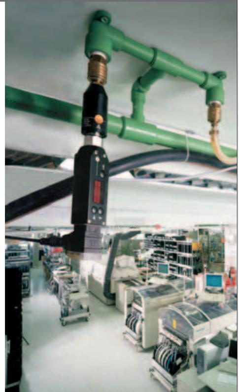
Lors d'applications critiques, le testo 6740 surveille l'humidité d'air comprimé directement devant l'utilisateur, par exemple dans la fabrication électronique.
