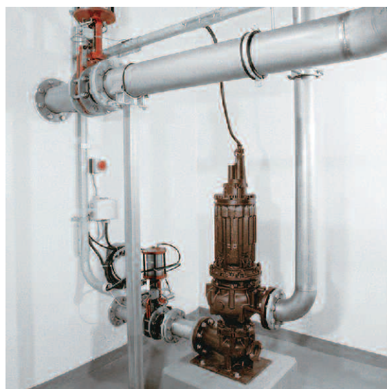
Pompe équipée d'une aspiration spécifique pour fonctionner à sec
