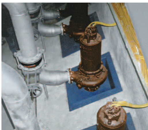
Pompes pour eaux usées en version fosse sèche.
