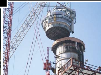
2004 Montage de colonnes de séparation en Inde.
