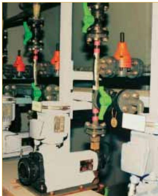
Pompage de chlorure ferrique en station d'épuration
