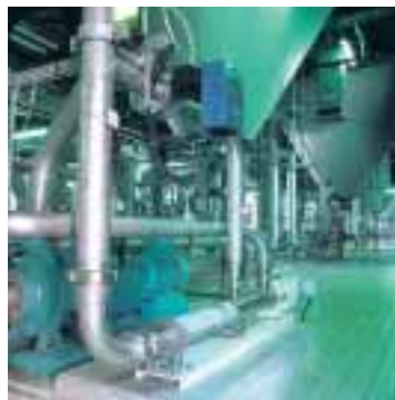
131A12 dans l'alimentation animale pour transfert et injection d'ingrédients (huiles, mélasses, enzymes...).
