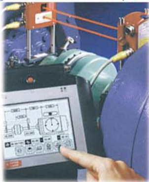
Alignement Laser sur pompes
