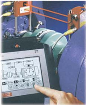
Alignement Laser sur pompes
