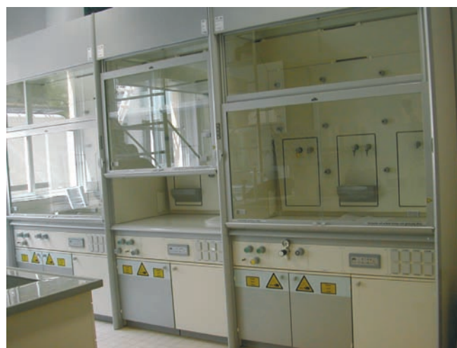
Sorbonne avec pilotage de ventilateur Ibiza par contrôleur. Insuflation d'air dans le local par CTA Modulys 350 - ECM
