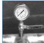
Manomètre à bain d'huile au refoulement pour mesure de pression
