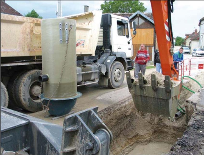
Installation d'un poste de relevage à Saint-Thibault (10)
