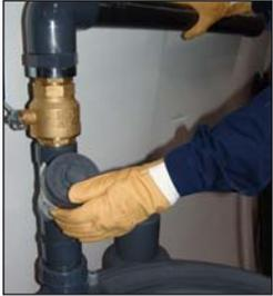
3. Raccordez la conduite de refoulement sur le bloc clapet-vanne. N'oubliez pas l'évent à l'arrivée.
