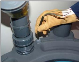
5. Passez le câble d'alimentation de la pompe dans le presse étoupe spécial. Les pompes monophasées seront raccordées à une simple prise 16A + T.
