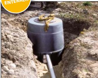
1. Selon la notice de pose simple et détaillée, la station est posée sur un lit de sable et lestée selon la nature du terrain.
