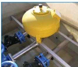
Ballon anti-bélier dans le regard pour protéger les systèmes de pompage et le réseau de refoulement.
