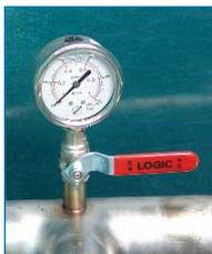
Manomètre à bain d'huile au refoulement pour mesure de pression.
